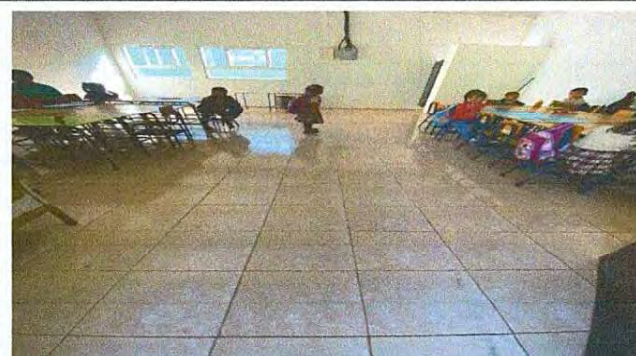
Foto 2: piso cerámico terminado.
