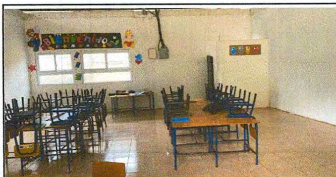
Foto 3: VISTA DEL PISO VENTANA Y BAÑO TERMINADO
