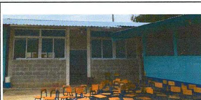
Foto 2: VISTA DEL TRABAJO DE LAS VENTANAS FINALIZADAS
