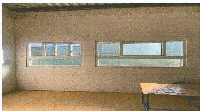
Foto 3: ventanas pvc instaladas.
